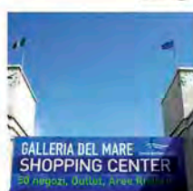
Galleria del mare
